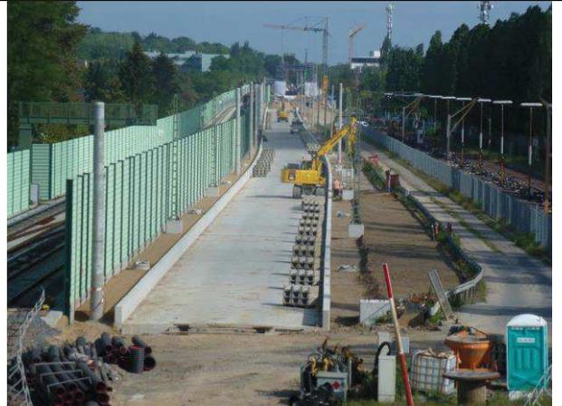
Kamenzer Damm Brücke Richtung Norden, feste Fahrbahn, Beton fertig
