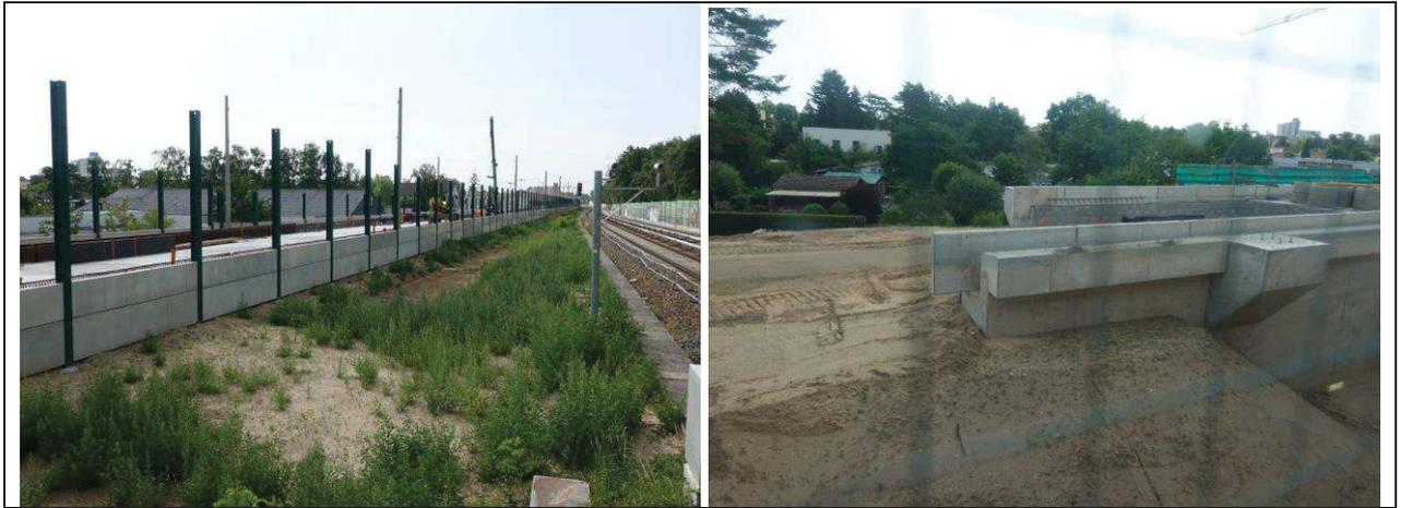
Dresdner Bahn Richtung Südosten, Oberleitungsmaste stehen, feste Fahrbahn fertig ohne geklebten schwingungsmindernden Gummi sowie Schotter.
